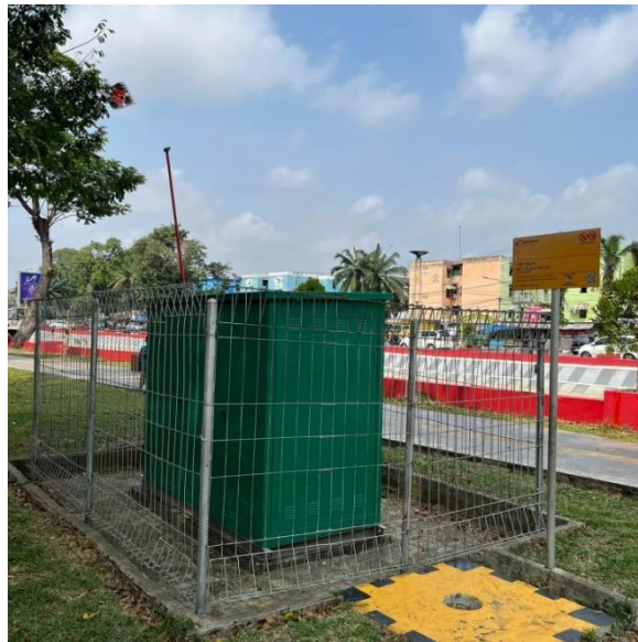
Sumber : Survey Lapangan, 2023
